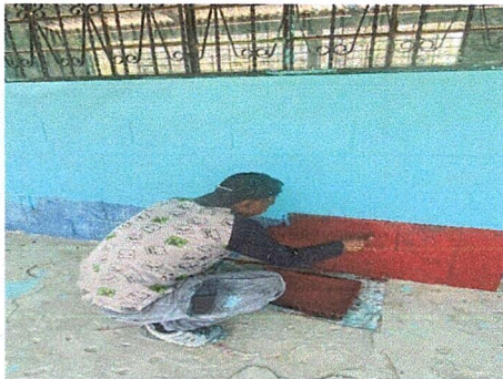
Foto 3: mejoramiento de pintura en interiores y exteriores
