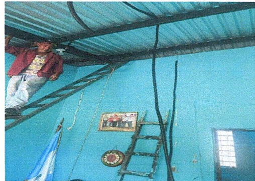
Foto 4: cambiando el sistema eléctrico en su totalidad
